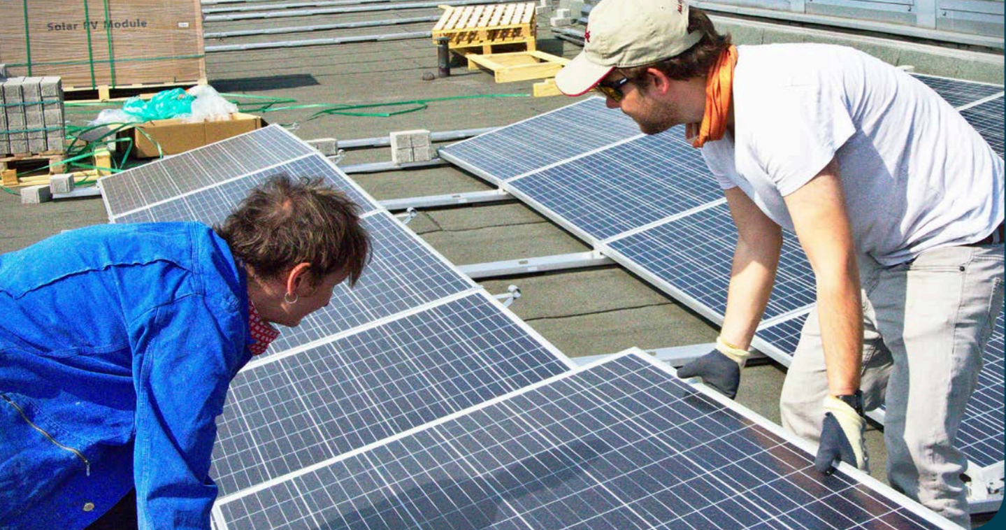
SoLocal Energy e.V. bei einem Selbstbau-Projekt auf dem Dach
