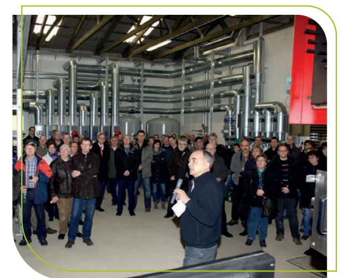
Feierliche Einweihung der Nahwärmezentrale
