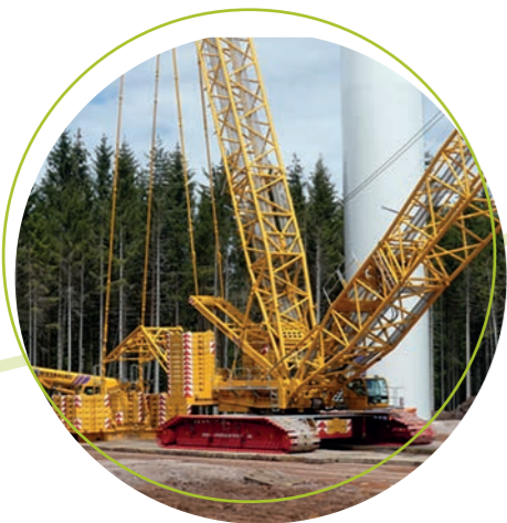
Bau der Windenergieanlage
