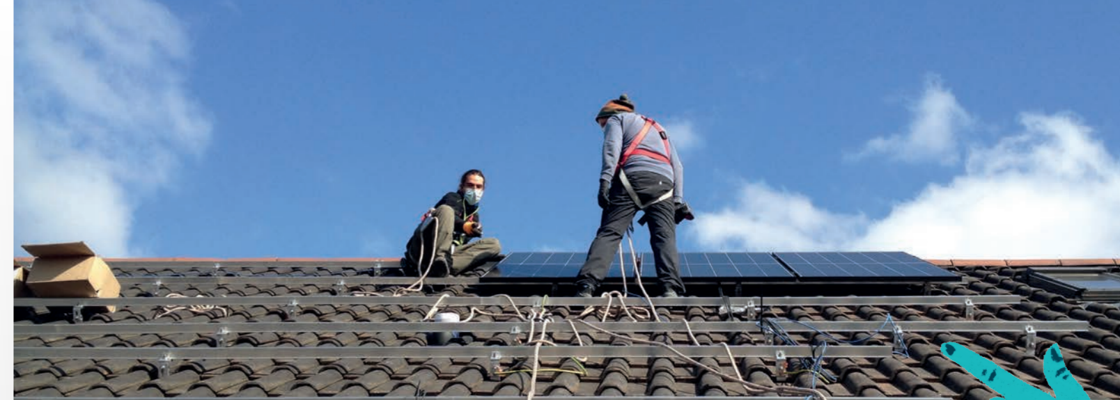
Montage einer kleinen PV-Dachanlage
