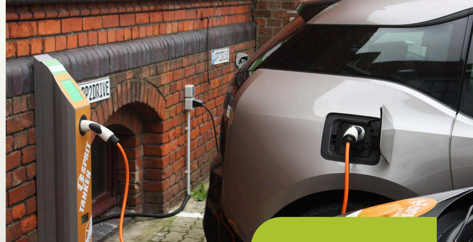
Ein E-Auto lädt erneuerbaren Strom an der Ladesäule.
